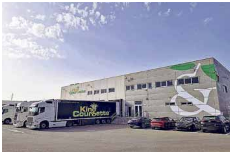
INSTALACIONES DE BERDEA SAT ubicadas en El Ejido.
